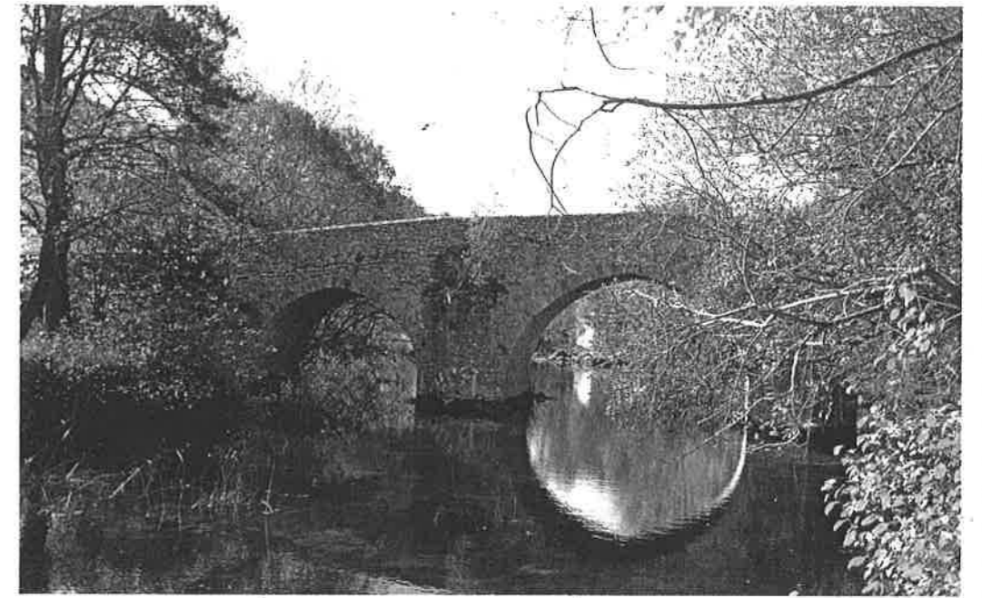
Puente de Criales de Losa
